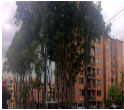
Foto No. 2 Existencia de complejo de apartamentos en Área aledaña a dirección aportada
