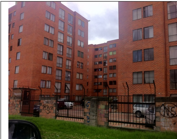
Foto No. 1 Evidencia de la existencia de construcciones de edificios en la Cra. 100 A con calle 71 A
